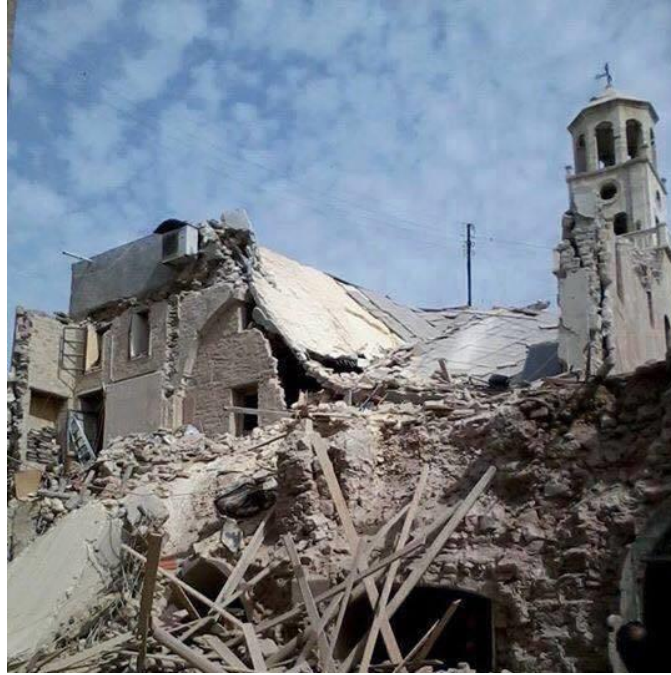
أضرار الواجهة الخارجية لكاتدرائية الأرمن الأرثوذكس Damage of the exterior façade of Kanisat al-Arman al-Urthuduks inews.media, (April 26, 2015)
