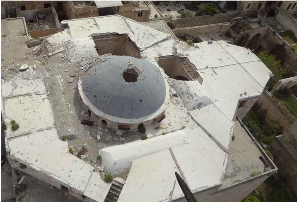
Prayer hall roof | سقف قاعة الصلاة
