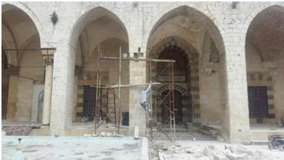
Repaired portico pillar | عمود الرواق بعد الإصلاح (© Nour al-Dean al-Tenbi, April 2017)
